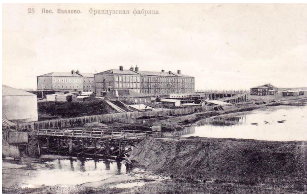
Строительство третьей казармы. Фото ориентировочно 1910-1911 гг.
